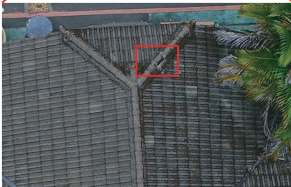
圖 147 每月例行使用無人飛機協助查看文化資產屋瓦狀態
