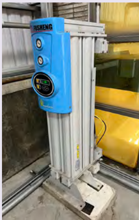
◀ 圖 7-135 壓縮空氣與冷卻除水設備
